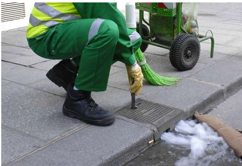
Ville de Paris : "coulage" des caniveaux avec de l'eau brute (non potabilisée)
