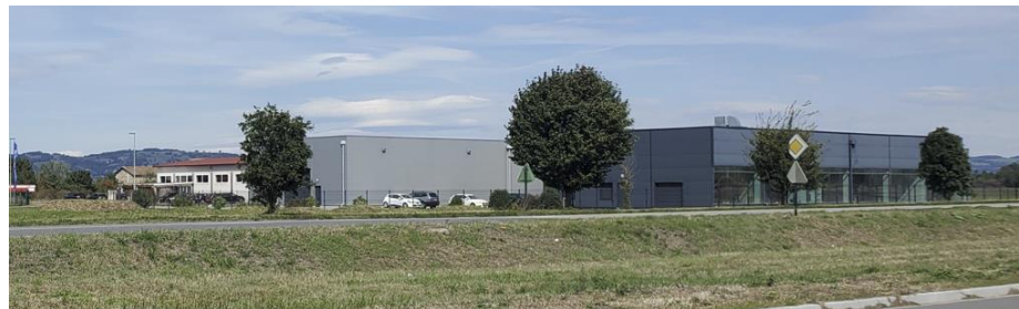
Références de constructions situées dans la zone d'activités à proximité de l'OAP
